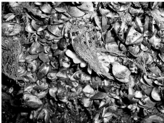
Обрастание дрейссеной гидросооружений на акватории Днепровского водохранилища
